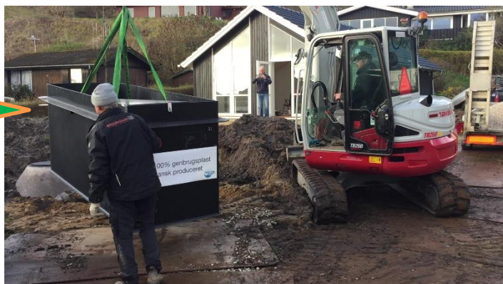
Karret i genbrugsplast løftes på plads i udgravningen.
