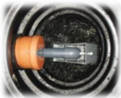
Hævert-pumpen vipper og spildevandet kommer med stødbelastning til rensningsanlægget.
