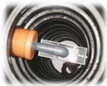
Hævert-pumpen i ligevægt mens spildevandet løber til.
