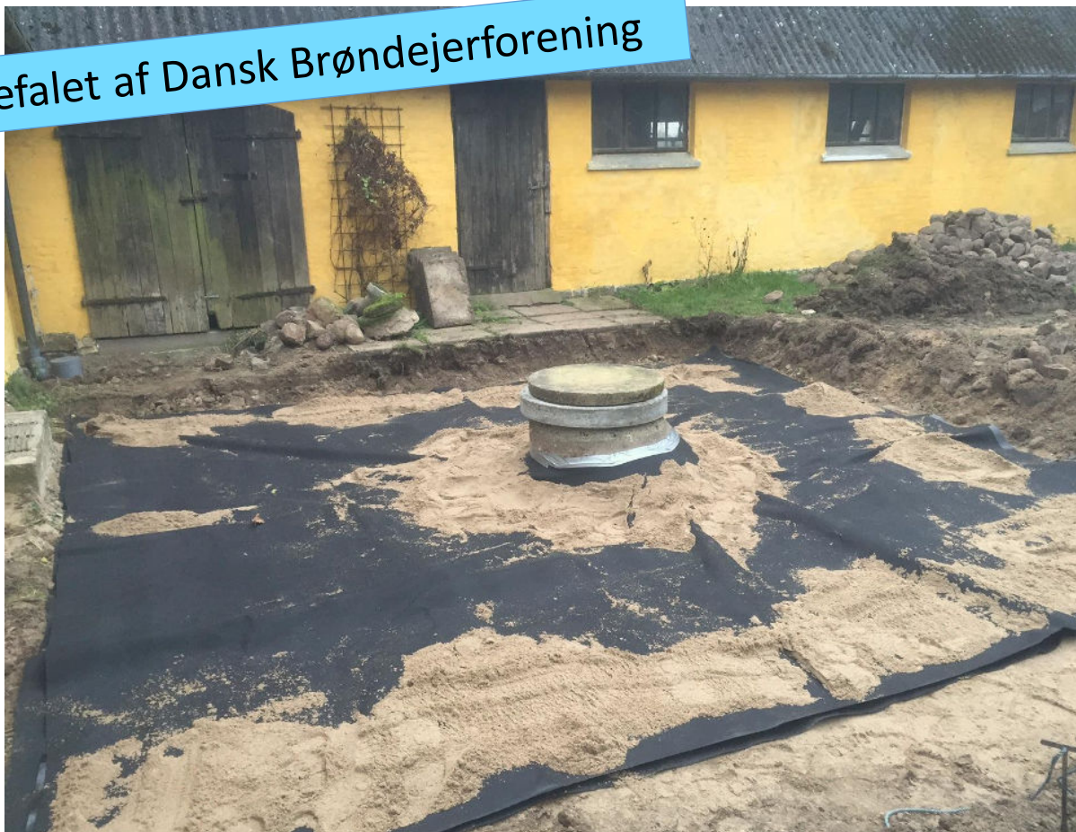
Brøndbeskyttelse under etablering
