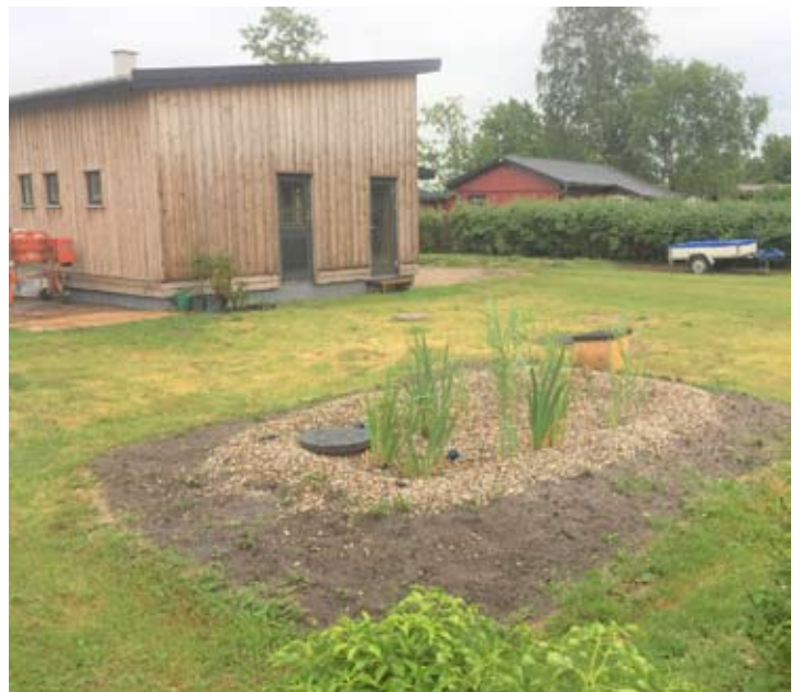
Foto: "Vi skider på livet løs, og vandet bliver renset." - siger sommerhusejer Hans Bruun fra Korsør med et smil på læben om sit nyinstallerede beplantede filter. Med tiden vokser planterne til og bedet integreres på den måde i haven.
