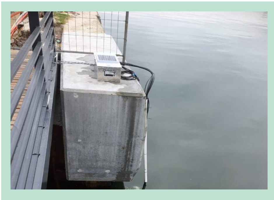
FIGUR 7. Testopstilling af automatisk prøvetager til udtagning af prøver i forskellige dybder.
