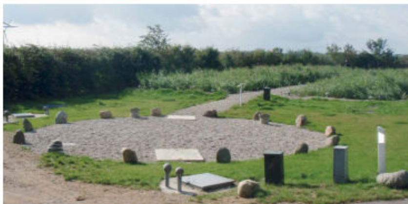
Beplantet filteranlæg i Tjørnelunde modtager i dag spildevand fra 36 husstande.
