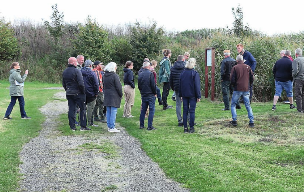
Cafeteriakroen i Hampen ligger i det åbne land og renser spildevand med et beplantet filteranlæg. Her er vi tæt på anlægget.
